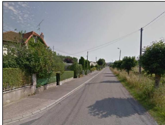
D22B, trottoir étroit seulement d'un côté de la voirie. Pas d'emplacements matérialisés pour le stationnement
