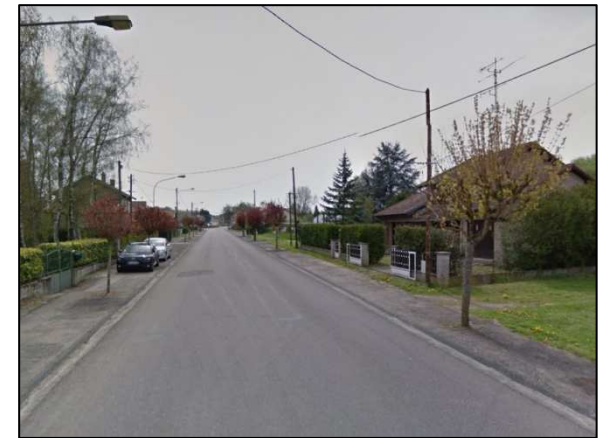
Avenue de Bayon, trottoirs de part et d'autre de la chaussée, ponctuellement utilisés pour stationner des véhicules.
