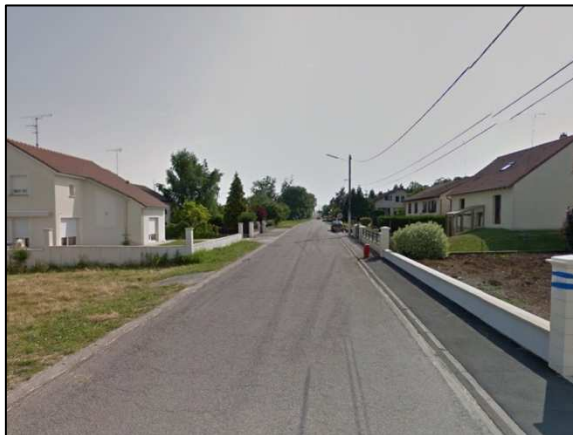
Chemin des chinois, trottoir étroit seulement d'un côté de la voirie. Pas d'emplacements matérialisés pour le stationnement
