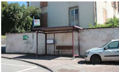
Abri bus rue de la République - ITB
